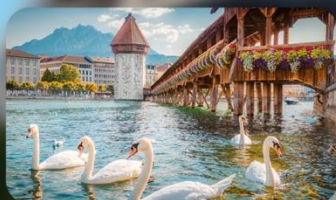
สะพานไมซ์าเปิล
